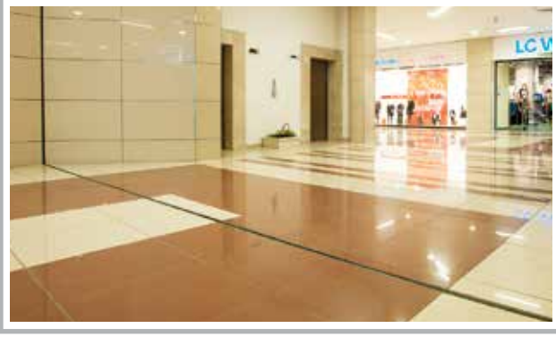
AR102-030 Zemin Dilatasyon & AR200-030 Duvar - Tavan Dilatasyon Profili Uygulaması
