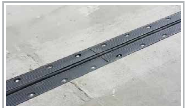
AR911-051 Zemin Dilatasyon Profili Uygulaması
