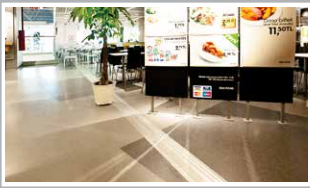
AR823-150 Zemin Dilatasyon Profili Uygulaması
