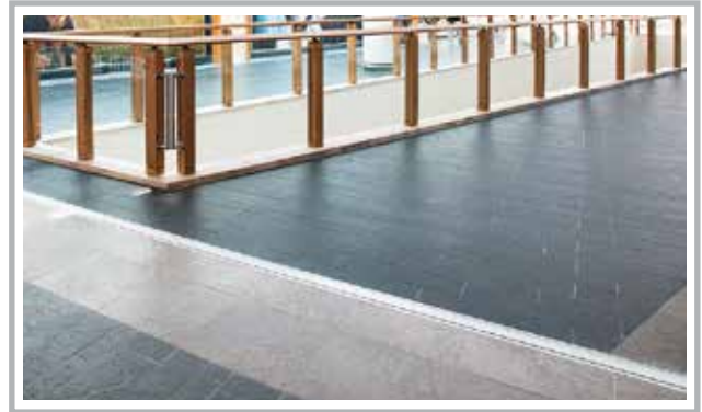
AR309-100 Zemin Dilatasyon Profili Uygulaması
