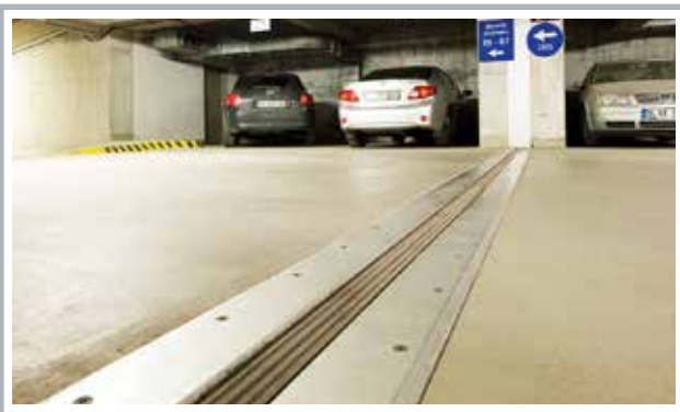
AR191-150 Zemin Dilatasyon & AR250 DT Duvar-Tavan Dilatasyon Profili Uygulaması
