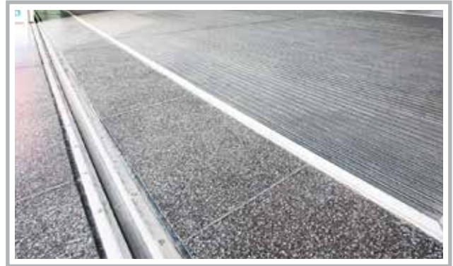
AR600-050 Tam Sızdırmaz Zemin Dilatasyon Profili Uygulaması
